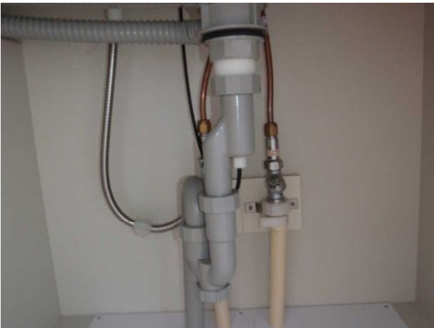
【洗面化粧台】 配管に漏れはありませんでした。
