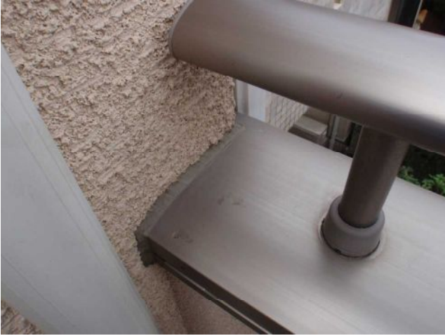
【バルコニー】 取り付け部分のシールは著しい劣化はみられません。
