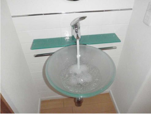
【廊下洗面台】 給排水に不具合はありませんでした。
