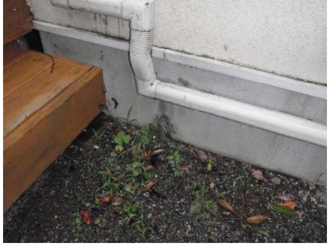
【基礎立ち上がり】 モルタル補修のような形跡がありましたが、特に浮いているなどの問題は無いようです。
