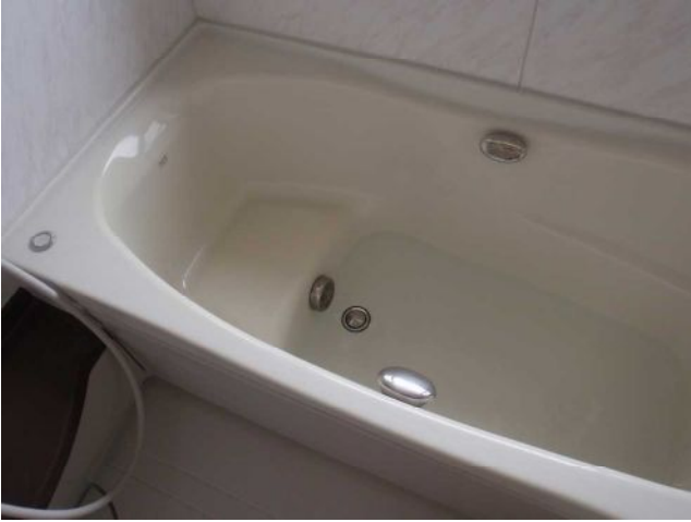
【浴室】 給排水に不具合はありませんでした。
