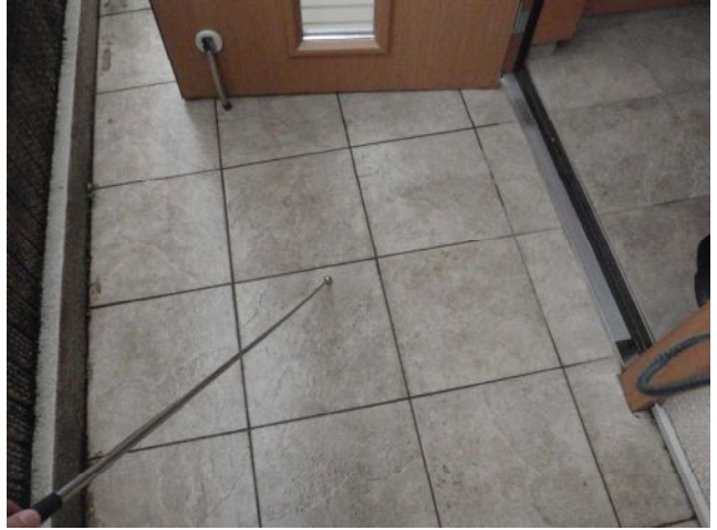
【玄関ポーチ】 ほぼ全体にわたり浮きや亀裂などの不具合は確認出来ませんでした。
