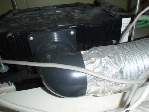
【浴室天井裏】 配管は適切に施工されていました。 排気漏れは確認されませんでした。
