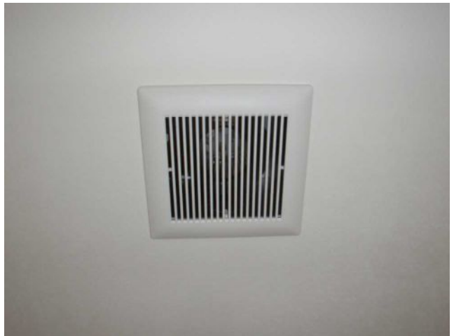
【洗面脱衣室】 換気設備に不具合はありませんでした。
