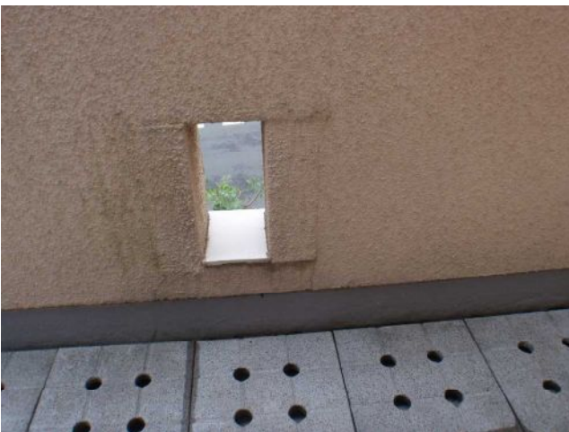
【バルコニー西側】 飾り窓付近に小さな亀裂がありました。
