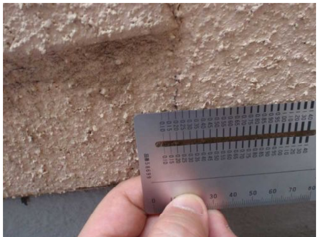
【バルコニー西側】 飾り窓付近に小さな亀裂がありました。 ひび割れ幅0.20mmとわずかな亀裂であり、特に問題 ないようです。
