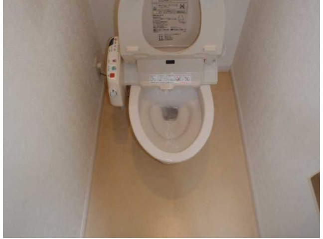
【2階トイレ】 給排水に不具合はありませんでした。
