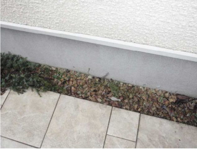
【基礎立ち上がり】 ほぼ全体にわたり浮きや亀裂などの不具合は確認出来ませんでした。
