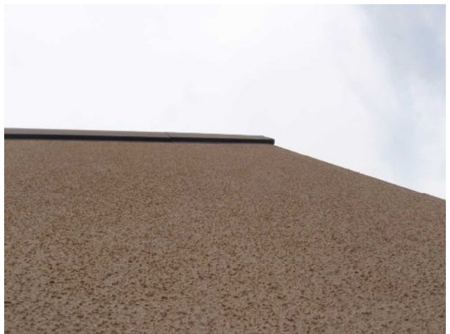
【外壁】 ゆがみや亀裂などの不具合は確認できませんでした。新築時の施工が適切であったと推測できます。
