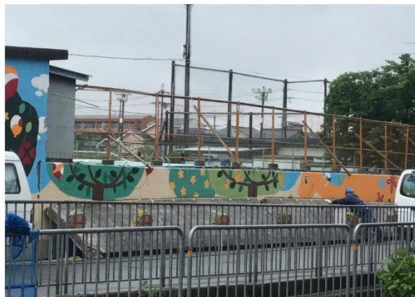
大阪府北部地震で倒壊した 小学校のブロック塀
