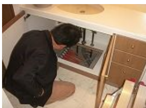
洗面台下の点検口
