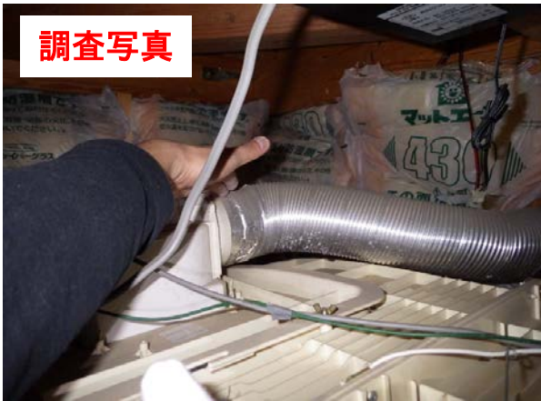
【 天井裏空調・換気設備 】
