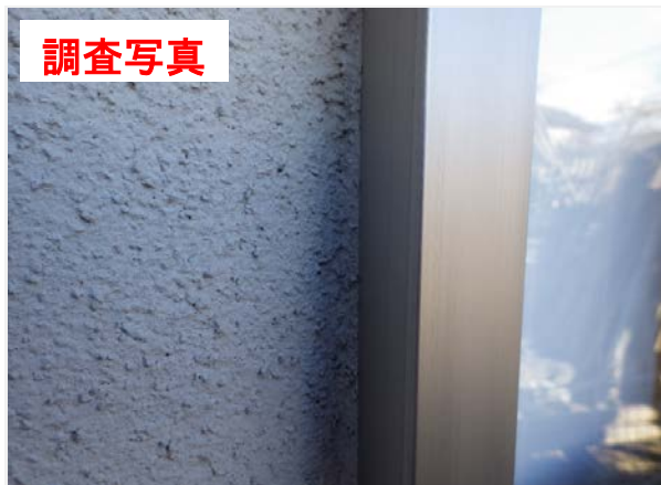
【 外壁仕上げ材表面 】
