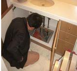
洗面台下の点検口
