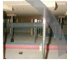
点検口から床下をカメラで撮影
