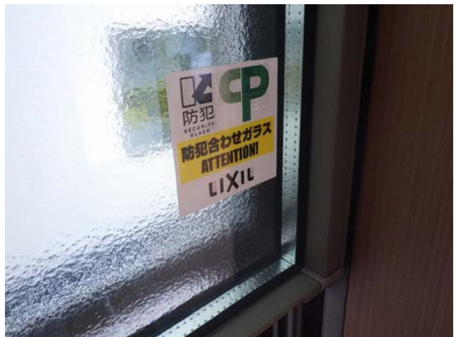
【室内】サッシ サッシはCPマークのついた防犯ガラスとなっており防犯上有効になっています。またペアガラスが採用されており断熱上有効な仕様になっています。
