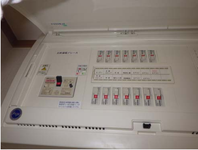
【室内】設備 分電盤を確認しました。50A、14回路・予備2回路でした。
