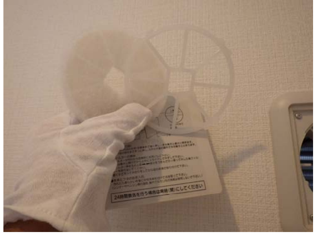
【室内】設備 給気口を確認しました。フィルターは年に2～3回程度清掃することをお勧めします。
