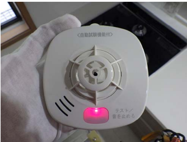
【室内】設備 住宅用火災警報器の作動状況を確認しました。正常に作動しており問題ありませんでした。
