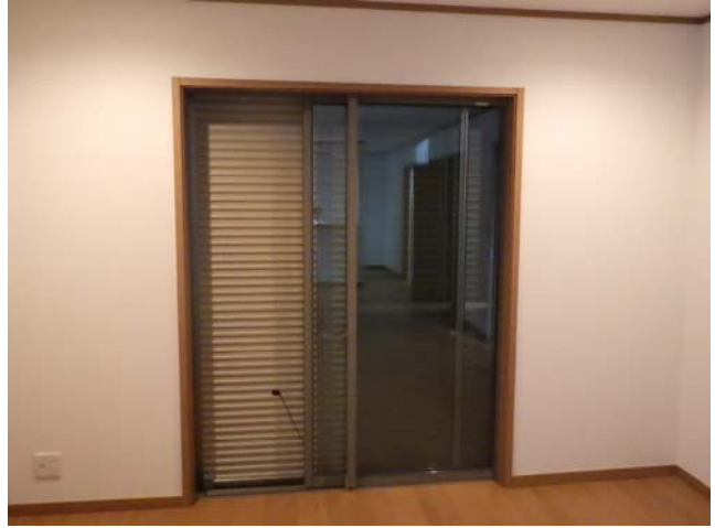
【室内】シャッター シャッターの開閉確認を行いました。スムーズに開閉され異音などの不具合は見られませんでした。
