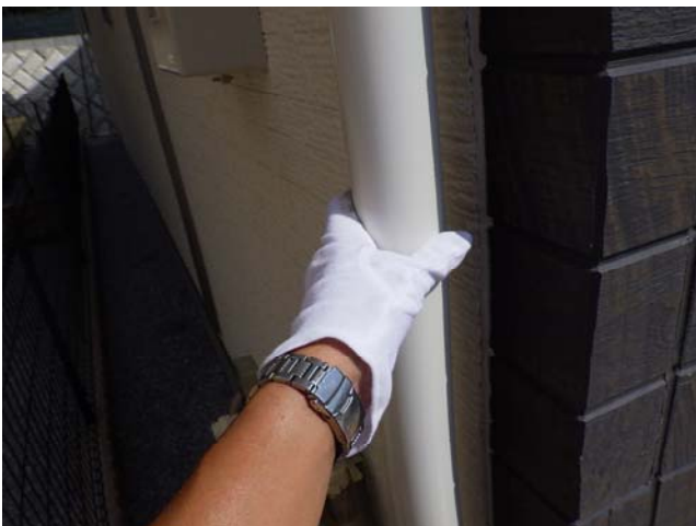
【外周り】 樋 確認を行った箇所の軒樋・縦樋の固定に問題ありませんでした。
