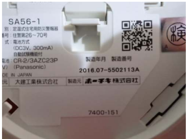
【室内】設備 住宅用火災警報器を取り外し製造年の確認をしました。2016年製でした。電池の寿命も概ね10年と推測されます。その時期になりましたら電池交換することをお勧めします。
