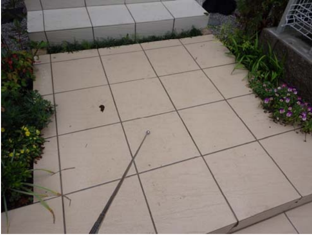
【外周り】 タイル 玄関ポーチタイルを打診棒で確認しました。浮きなどの不具合は見られませんでした。
