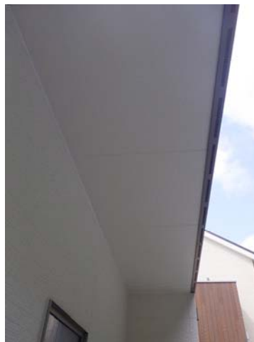
【外周り】 軒裏 軒裏（東側バルコニー付近）を確認しました。雨染みなど不具合を疑う形跡などなく問題ありませんでした。
