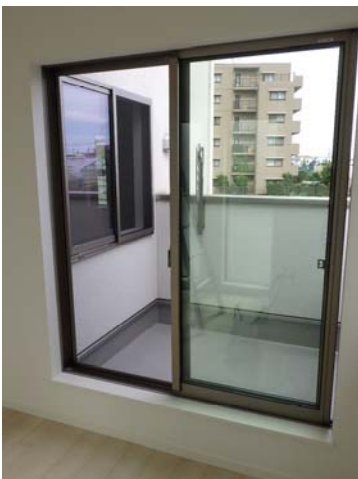
【室内】サッシ 全体的にサッシの開閉確認及び鍵の動作確認を行いました。スムーズに開閉され異音などの不具合は見られませんでした。
