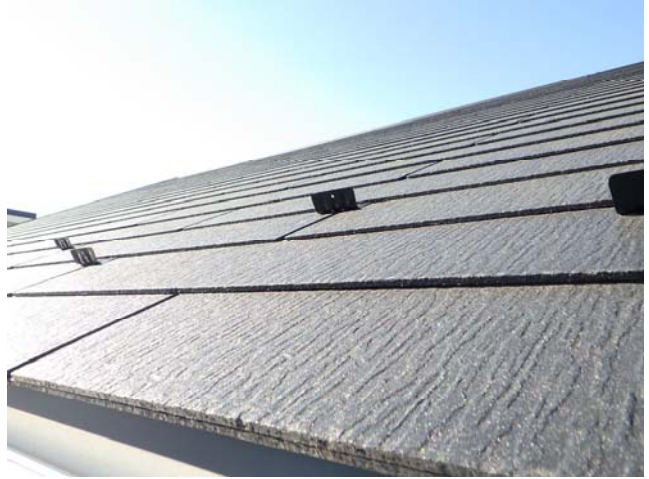
【外周り】 屋根 ベランダより自撮り棒にデジタルカメラを取付、屋根を撮影しました。確認できた範囲で屋根・雪止め金物の変形など不具合を疑う形跡はありませんでした。
