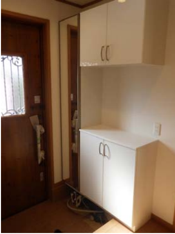
【室内】下駄箱 下駄箱を確認しました。扉の開閉に異音などの不具合は見られませんでした。
