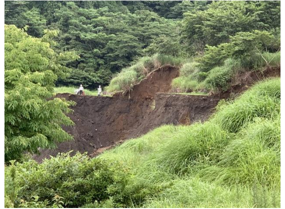
2021年7月に発生した熱海市の土石流は山林の盛土（残土）を起点として発生した
