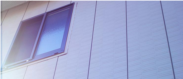
①外壁を高圧な洗浄機で洗う 外壁を傷めてしまうこともあるので注意
