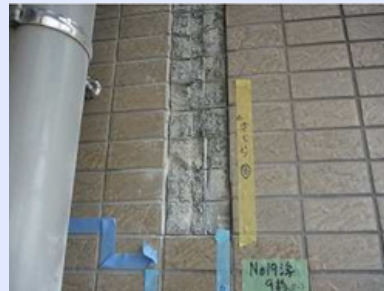
事例① 構造スリットなど複数の瑕疵発覚 解決までに5年を要した
