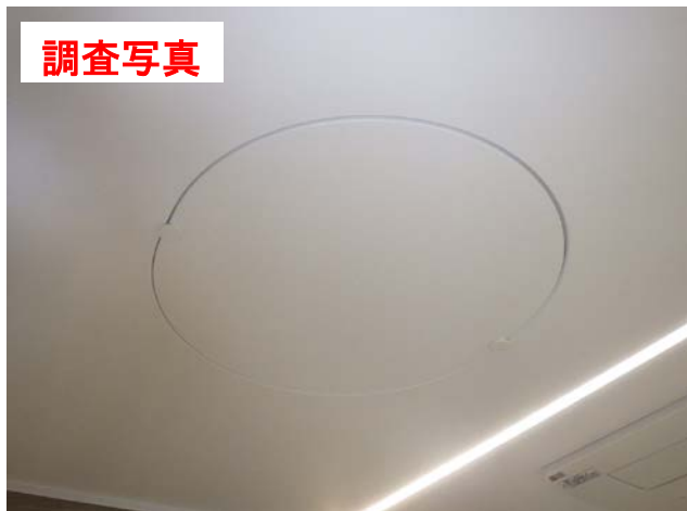
【屋根裏・天井裏】
